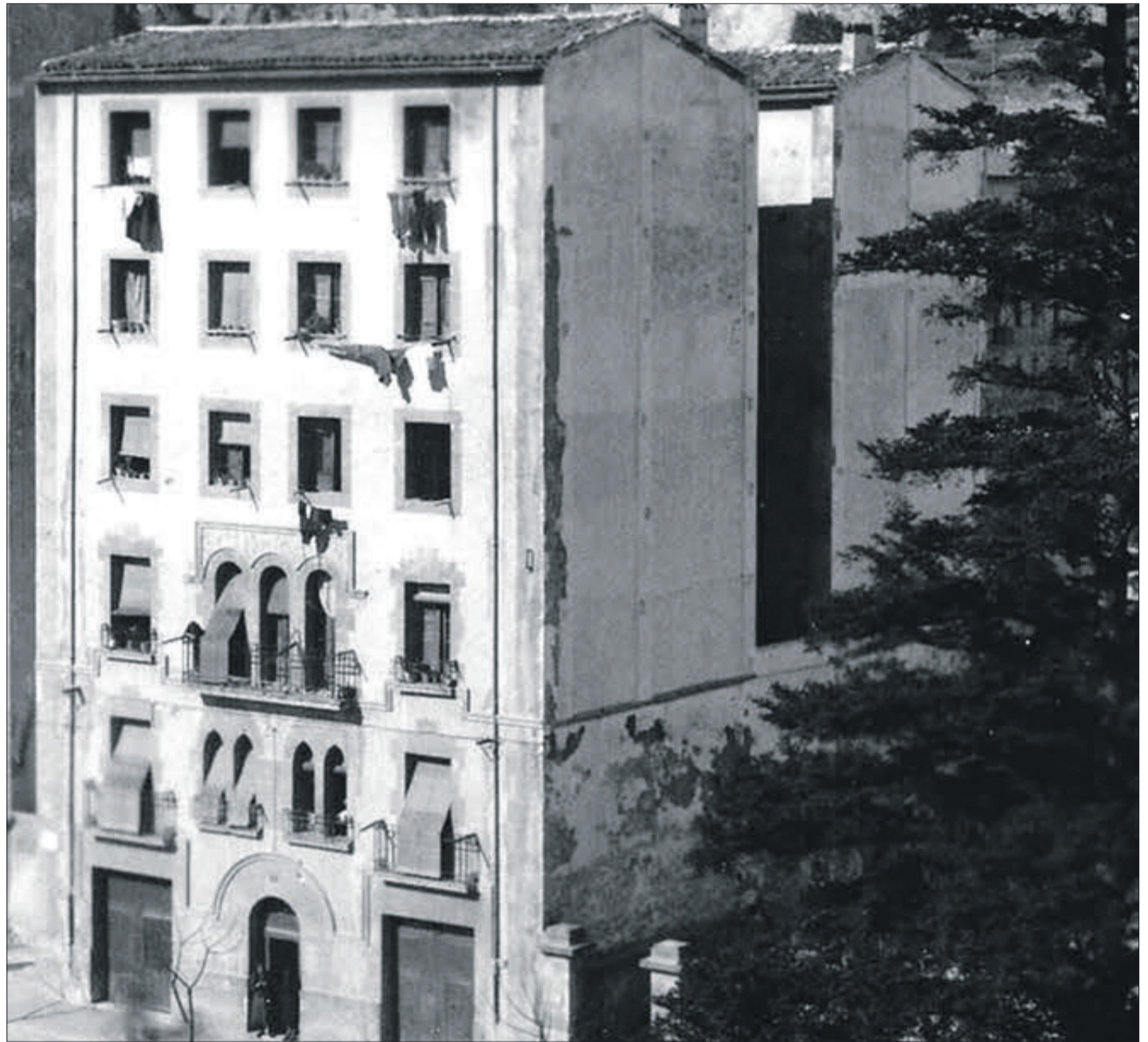
Edificio de la Casa Abadía.
