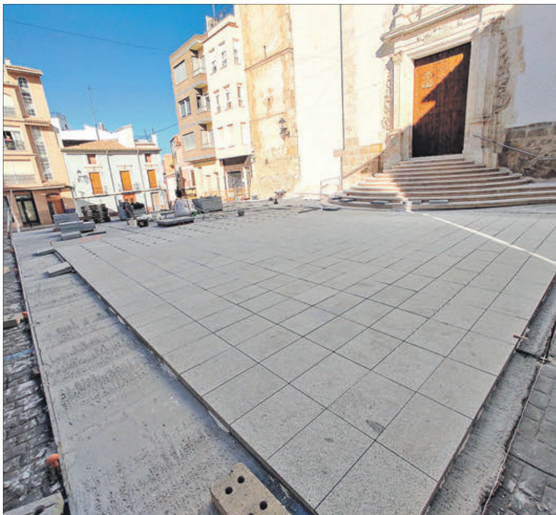
Ja s'està col·locant el nou paviment en la plaça.
