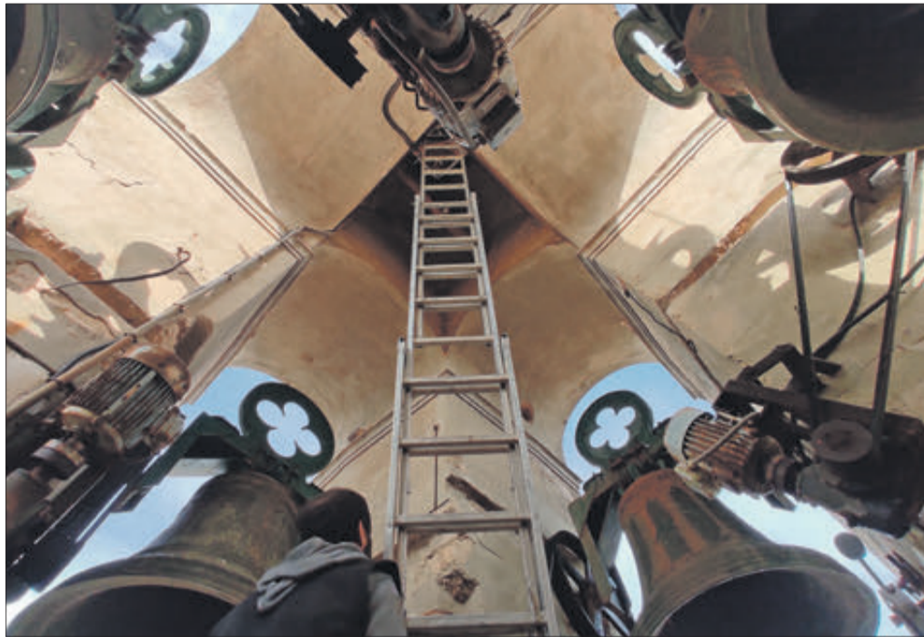
Interior del campanar amb les campanes.
