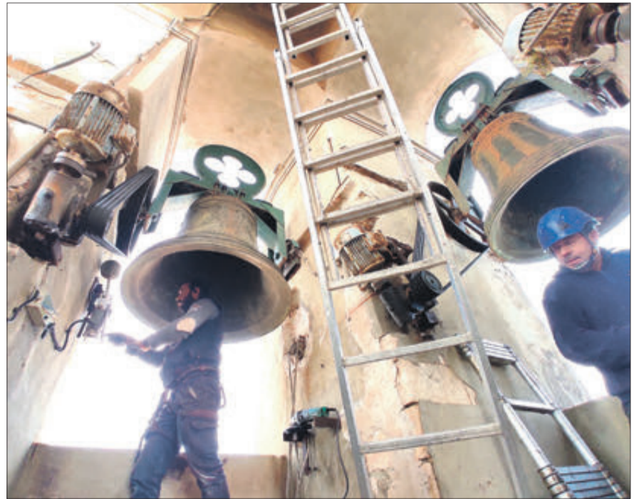
Operaris durant els treballs del desmuntatge.
