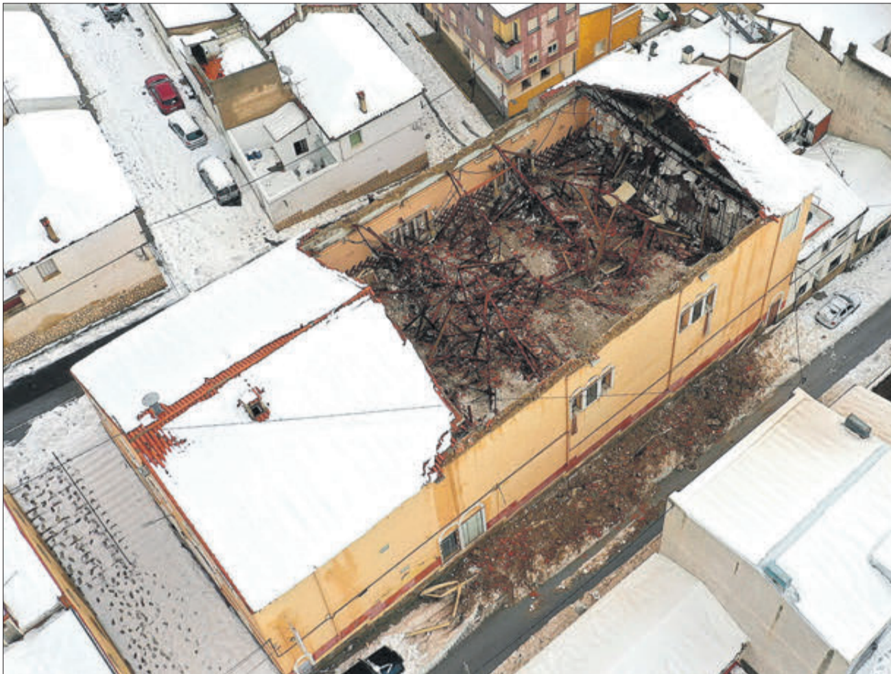
Estat en què va quedar el saló Mariola després de desprendre's la coberta.
