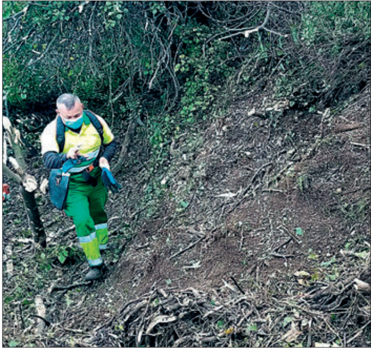
Un operari fent treballs de desbrossament en el vessant del Sant Crist.
