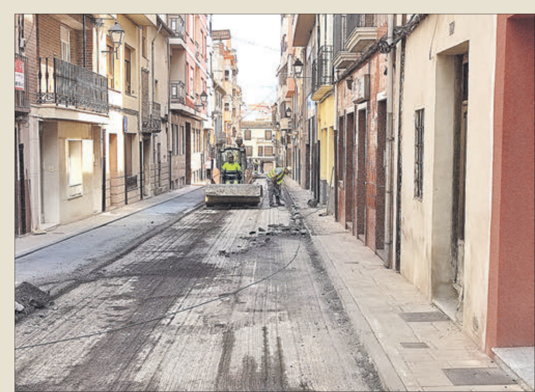
Un instant de l'execució de les obres.
