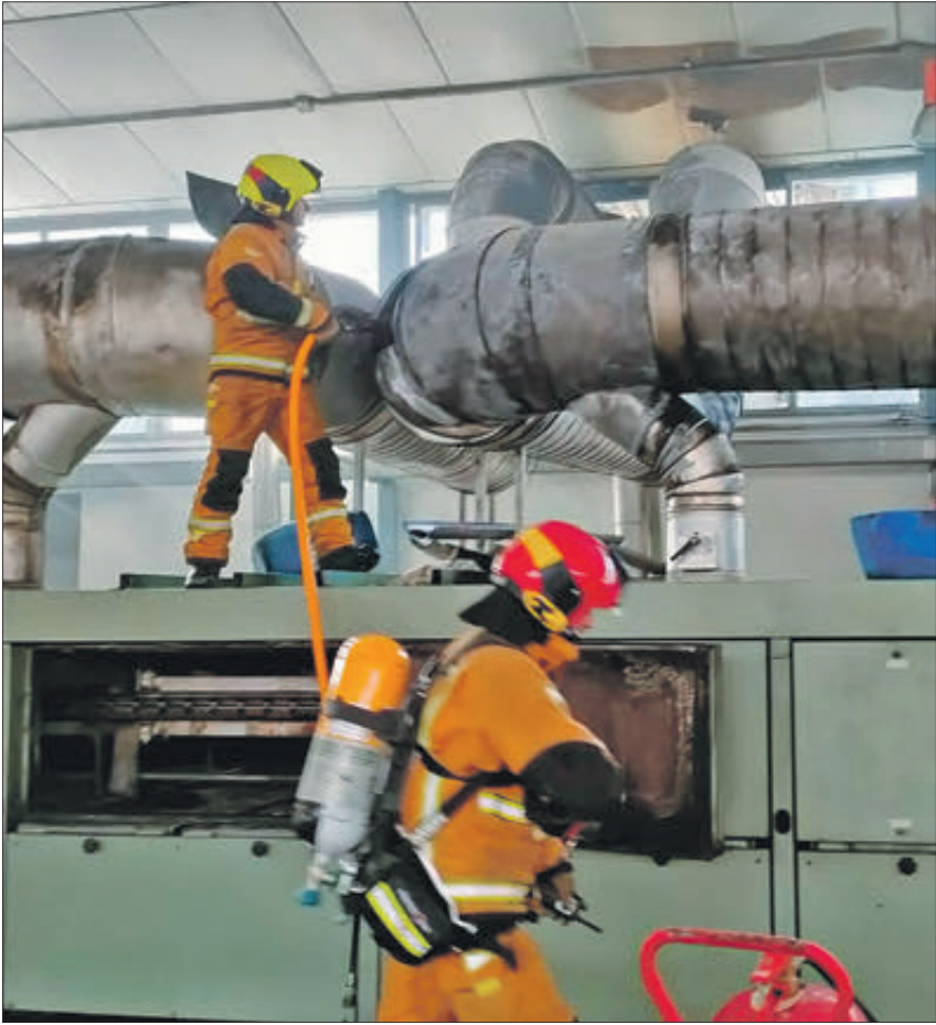
Bombers treballant en la instal·lació afectada.
