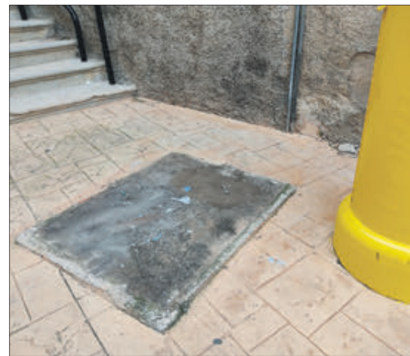
Això queda de la desapareguda cabina.
