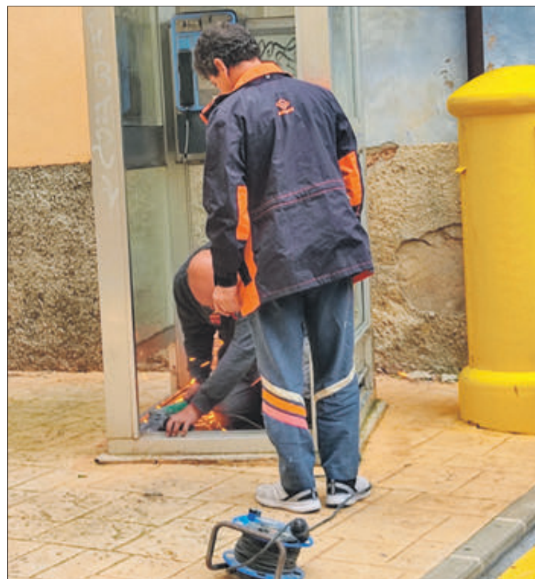
Amb una radial es van tallar les subjeccions al paviment.
