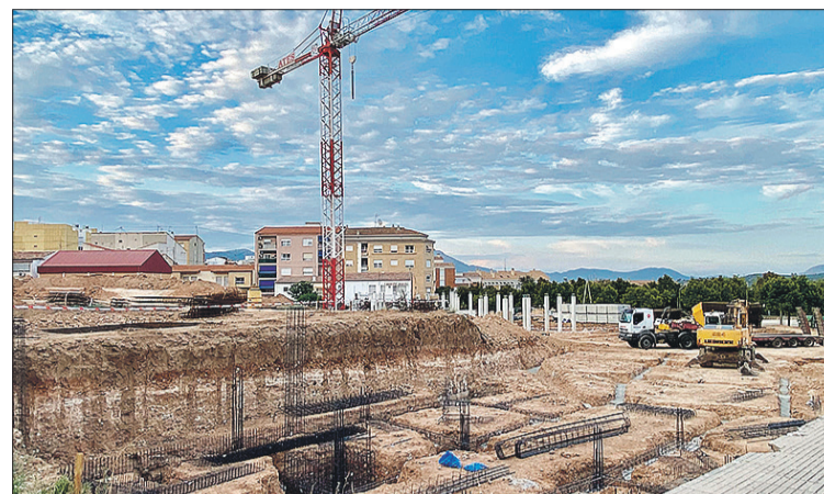
La estructura del nuevo Bosco comienza a ser visible. Gabriel Pascual
