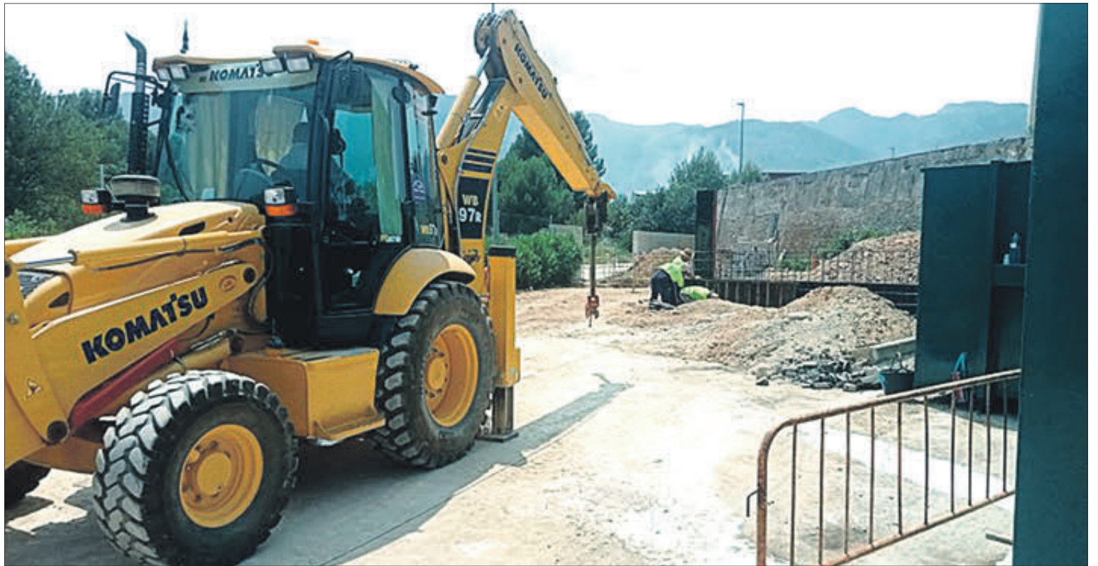
Les obres en l'ecoparc de Muro han anat avançant durant l'estiu.
