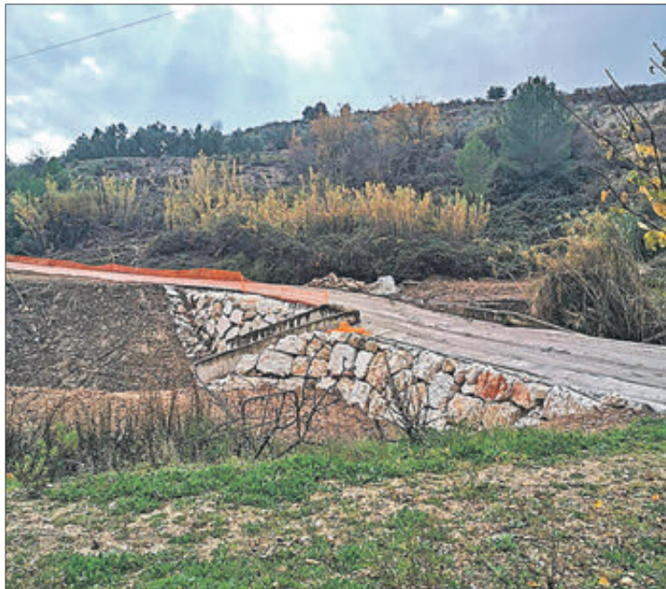
Part dels treballs realitzats. (Foto: Ajuntament de Muro)
