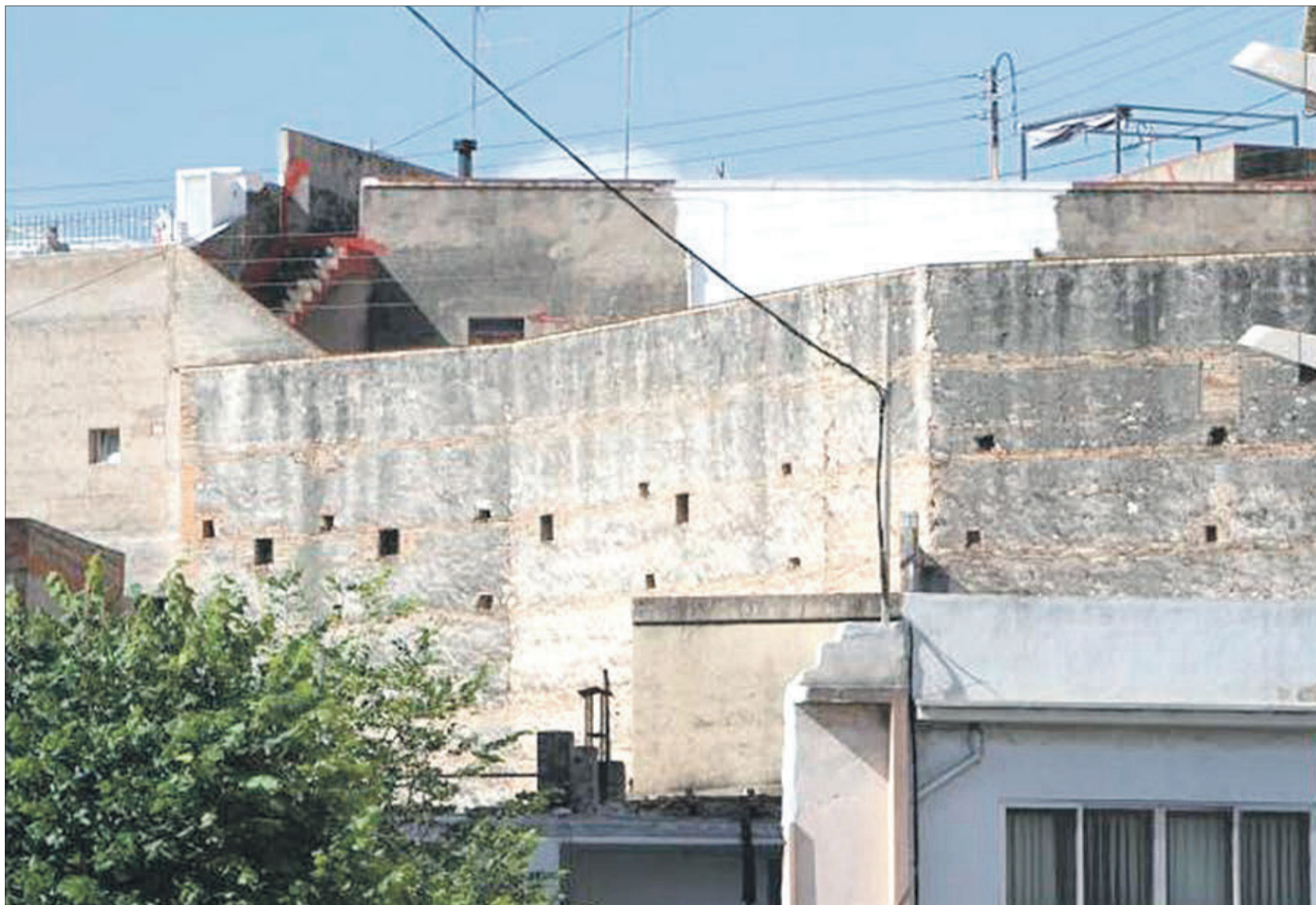
La muralla que ha eixit a la llum després de ser demolit l'edifici la Cambra Agrària.
