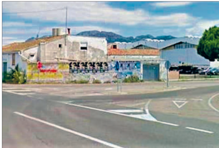
Encreuament Hostal Sant Jaume d'Oliva, en obres en uns mesos.
