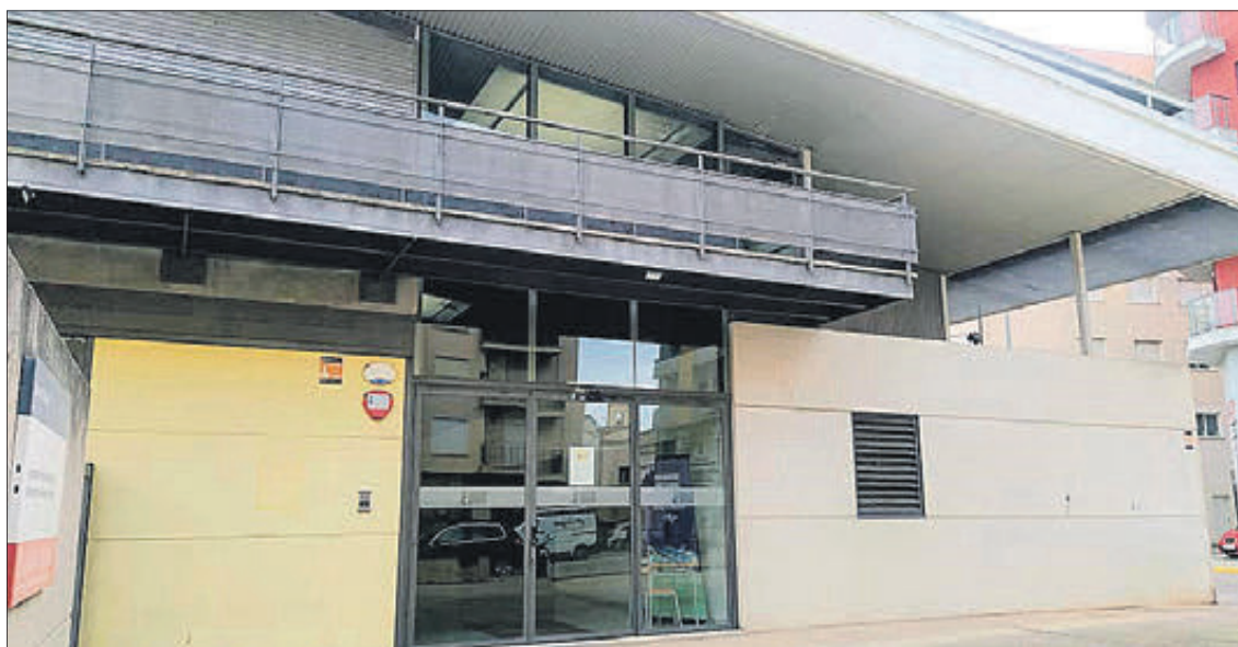
Façana de l'edifici del Conservatori.
