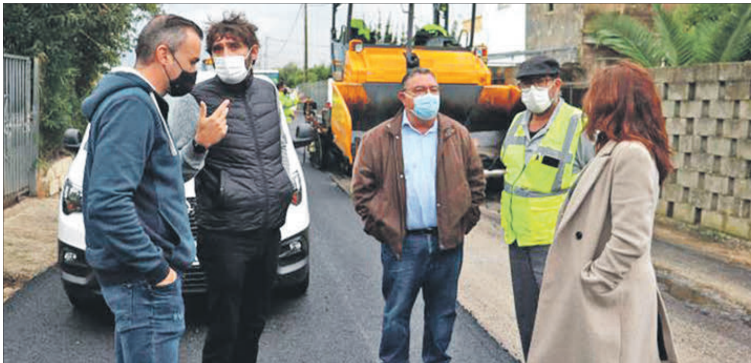
Visita a les obres que s'estan realitzant.
