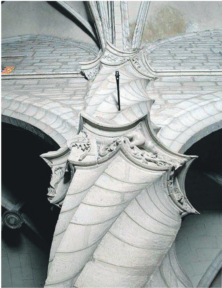
Detalle de las columnas helicoidales de la iglesia arcedial de Santiago de Villena. Foto Villena Cuéntame
