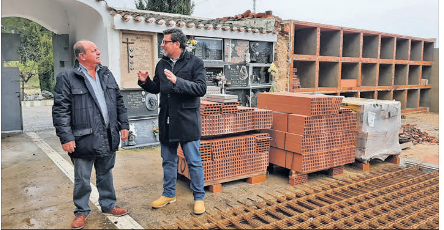
El diputat d'infraestructures i l'alcalde de Millena inspeccionen les obres del cementeri
