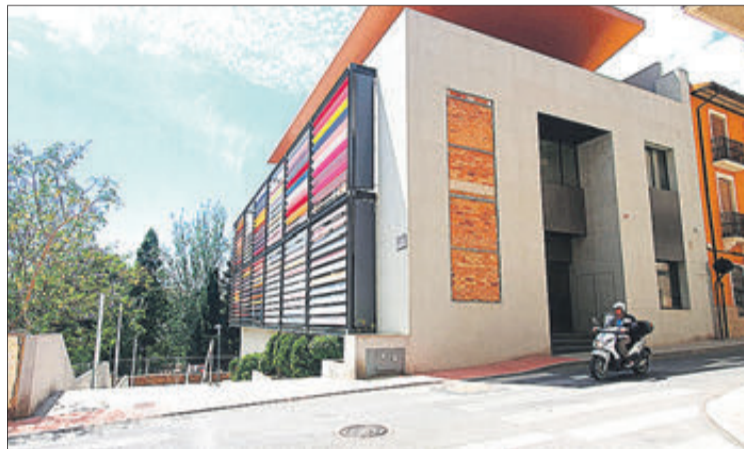
Edifici del futur centre de dia.
