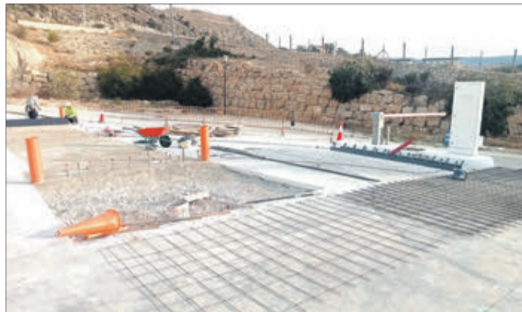
Trabajos que se están llevando a cabo en los ecoparques.
