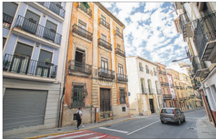
La Casa Aracil serà rehabilitada.
