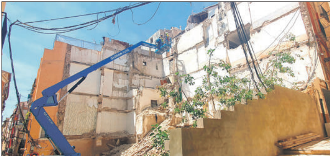
Treballs de demolició de la finca.
