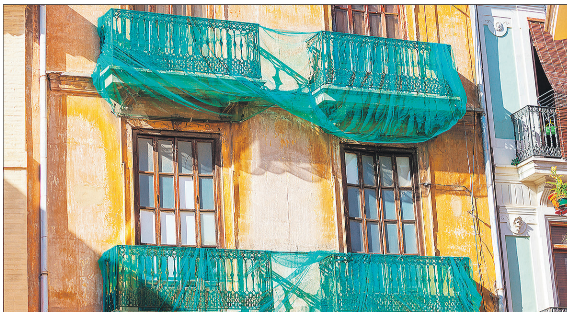
Fachada de un edificio pendiente de rehabilitación.
