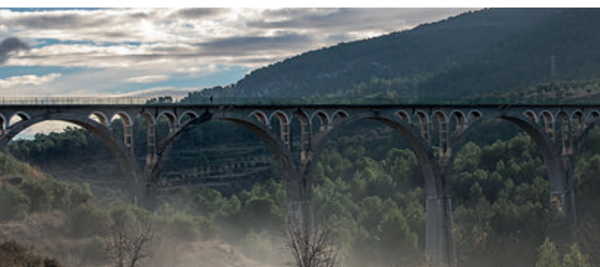
La Vía Verde atraviesa el Pont de les Set Llunes.
