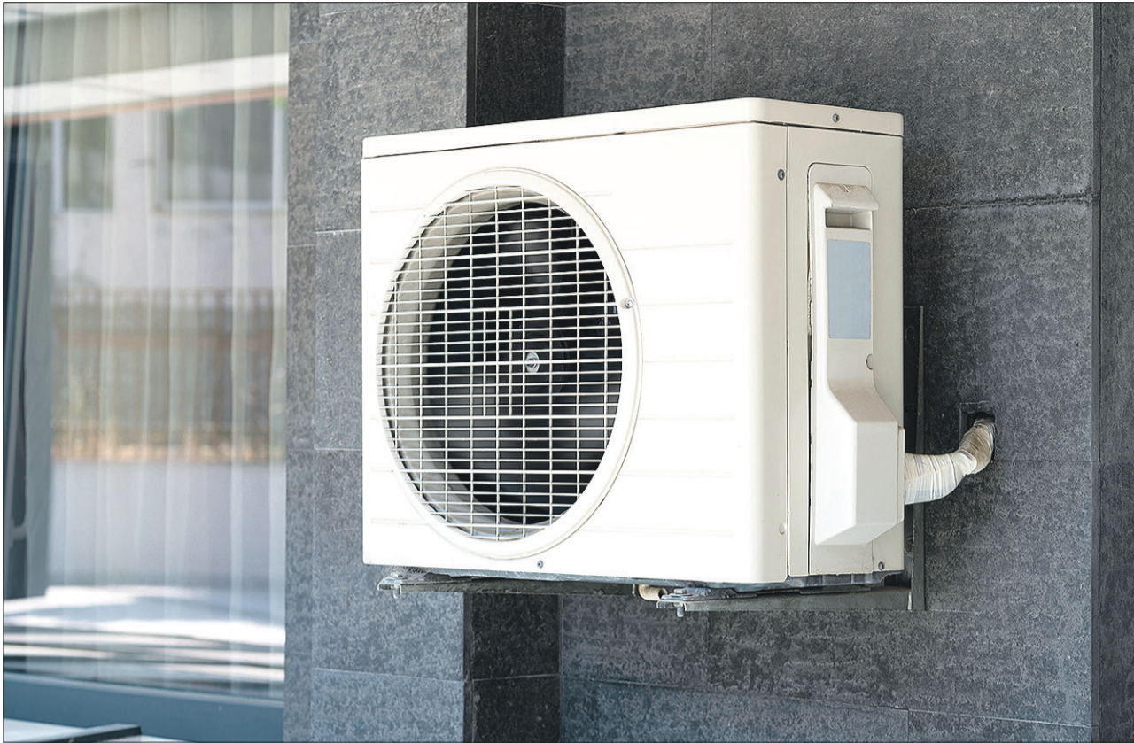
Una unidad exterior de un equipo de aire acondicionado.
